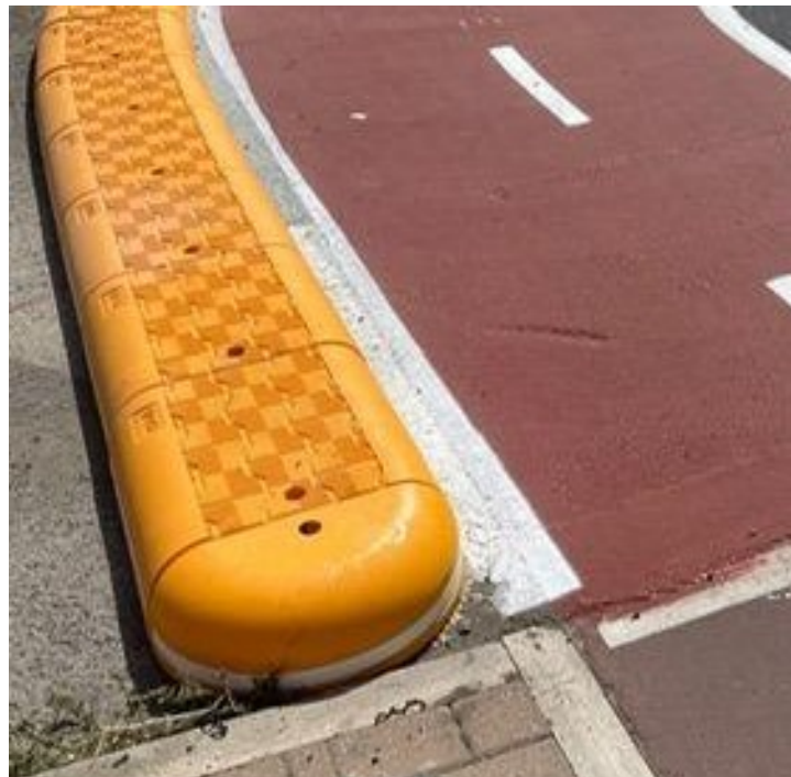
Cordolo in plastica per i tratti del Lungomare San Vito, Hopps e Mazzini
